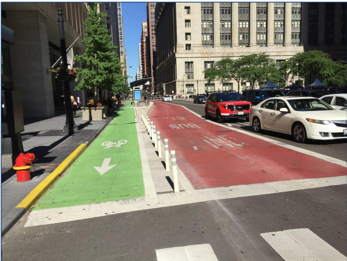
Bild 9: ADFC / Burkhard Stork, Protected Bike Lane in Chicago (USA), ausgestattet mit Flexposts neben einer Busspur und weiteren Kfz-Fahrspuren
